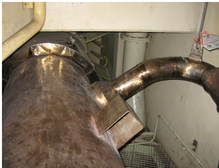
Figure 1 : RIB Nozzle (1 per loop, 3 per unit)
