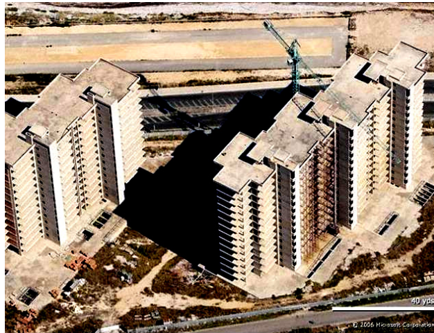
Figure 1: Punta Perotti building
