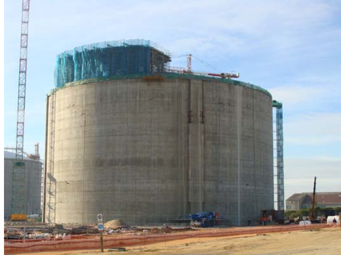
Fig. 1: LNG storage tank under construction
